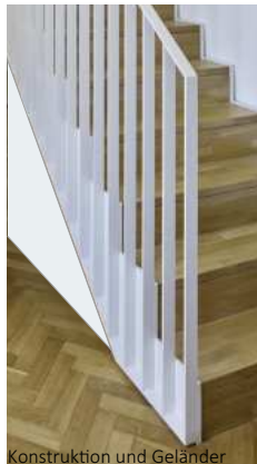
Konstruktion und Geländer
